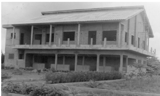
Siège du CIPCRE -Bénin en chantier.
