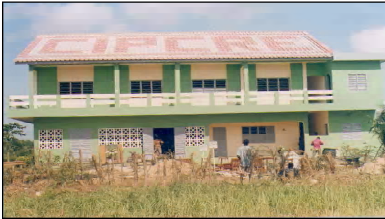
Siège du CIPCRE-Bénin (vue de derrière)
